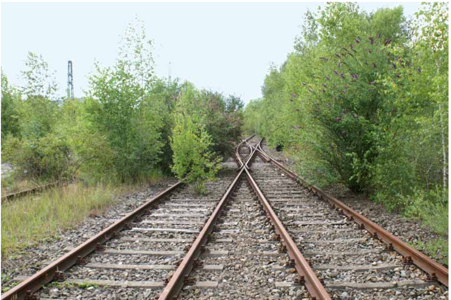
Die großen Bahntrassen vernetzen die Trockenlebensräume in Ost-West-Richtung durch das Stadtgebiet
