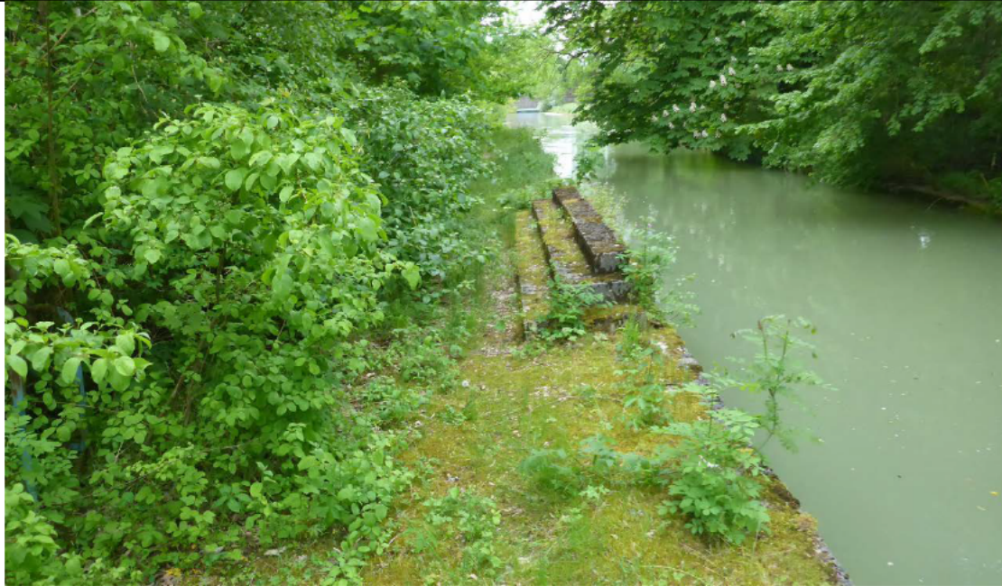
Abb. 8: Zwischenbereich zwischen Becken (links) und Mühlbach
