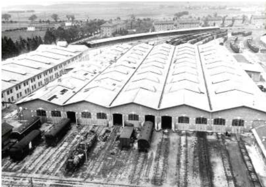
Werkhallen um 1940 (Untere Denkmalschutzbehörde)
