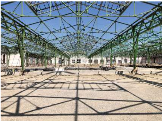
Stahlfachwerkkonstruktion nach der Entkernung
