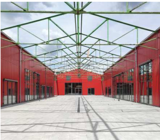
Neu entstandener Innenhof mit Bestandstragwerk
