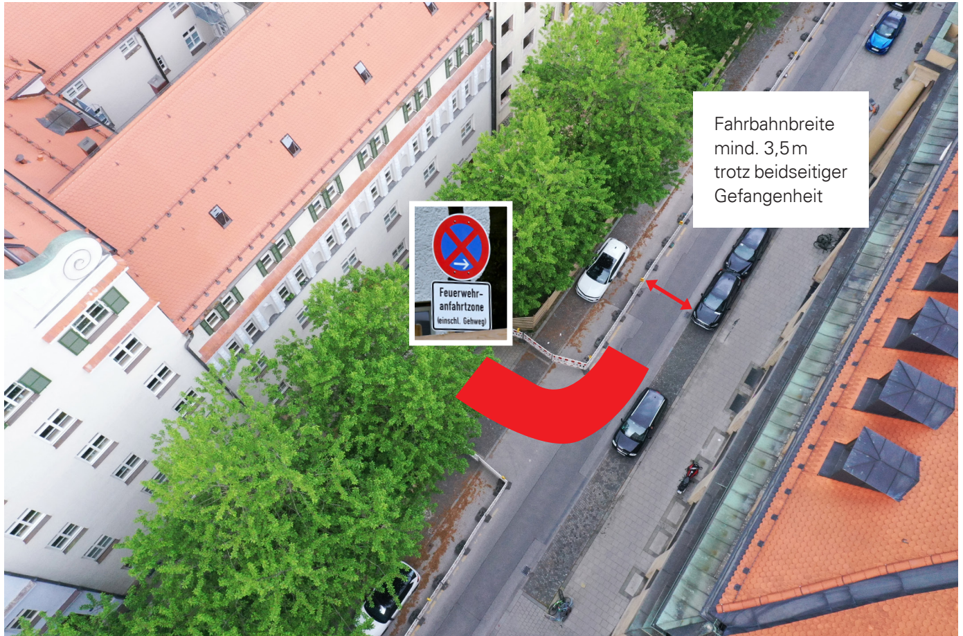
Verengte und gefangene Fahrbahn mindestens 3,5 Meter und Feuerwehrzufahrt
