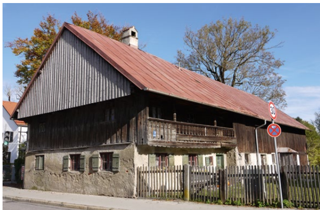
Der Mitte des 18. Jahrhunderts errichtete Derzbachhof, vormals Feichtbauer, gilt als ältester Bauernhof Münchens. Die Aufnahme oben entstand zu Beginn der 1920er Jahre, die Aufnahme unten rund 90 Jahre später, im Jahr 2012.
