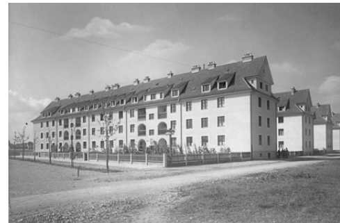
Die Arbeitersiedlung an der Zielstattstraße/Nelkenweg entwarf Theodor Fischer 1918 für den „Verein für Verbesserung der Wohnungsverhältnisse in München e.V.“. Sie wurde in späteren Jahren bis zur Boschetsrieder Straße erweitert. Ansicht aus den 1920er Jahren
