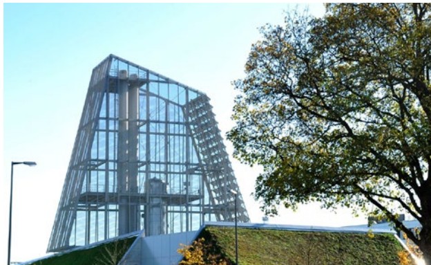
Die Energiezentrale Freiham an der Bodenseestraße
