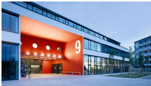
Noch vergleichsweise neu ist der Gewerbehof Westpark an der Adi-Maislinger-Straße. Er wurde im Januar 2020 eröffnet und bietet 7.100 Quadratmeter Fläche.
