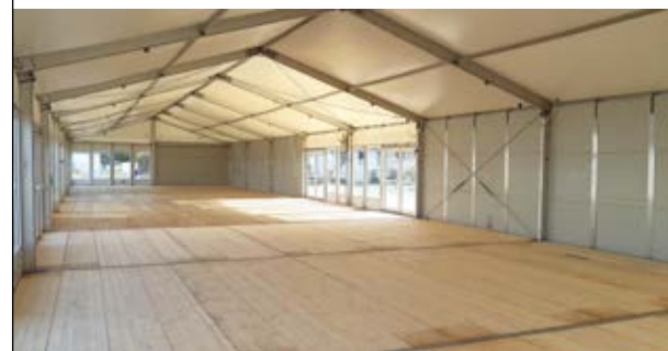
Auch vier Leichtbauhallen werden für geflüchtete Ukrainer*innen errichtet.
