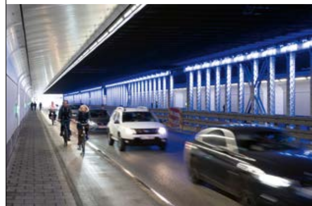
Die Paul-Heyse-Unterführung zeigt sich nach der Sanierung heller und sicherer.
