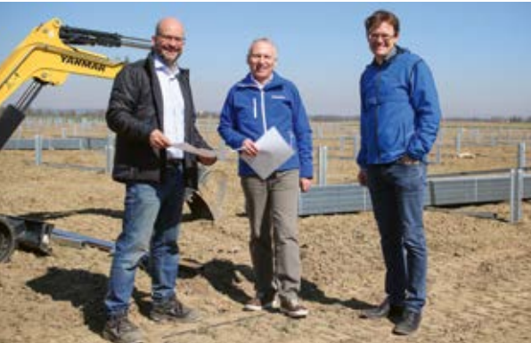
Baustart für die Freiflächen-Photovoltaik-Anlage Niederhummel mit Helge-Uve Braun, Technischer Geschäftsführer SWM (M.), Projektleiter Florian Schaeetz (I.) sowie dessen Stellvertreter Daniel Ströbele (r.).
