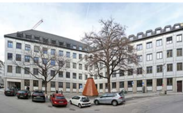
Das Gebäude an der Hackenstraße 12 wird zum Haus der Kinder- und Jugend-gesundheit umgebaut.
