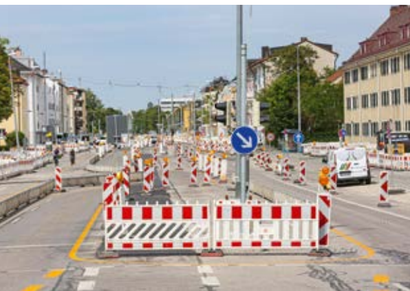
Baustelle für die Verlängerung der U5 in der Gotthardstraße.
