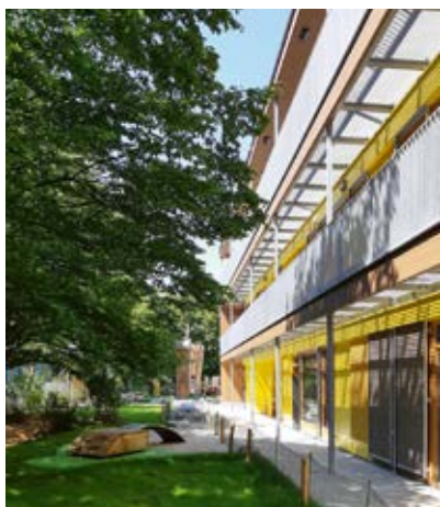
Seit 2011 wurden im Zuge des Kita-Bauprogramms 91 Kindertagesstätten neu errichtet, wie hier an der Bäckerstraße. Mit dem Bauprogramm 2022 kommen fünf weitere hinzu.
