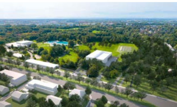
Auf einem Teilgelände des Michaelibads wollen die Stadtwerke ihre siebte Geothermieanlage errichten.
