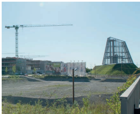
Das Geothermieheizwerk versorgt Freiham mit erneuerbarer Energie.
