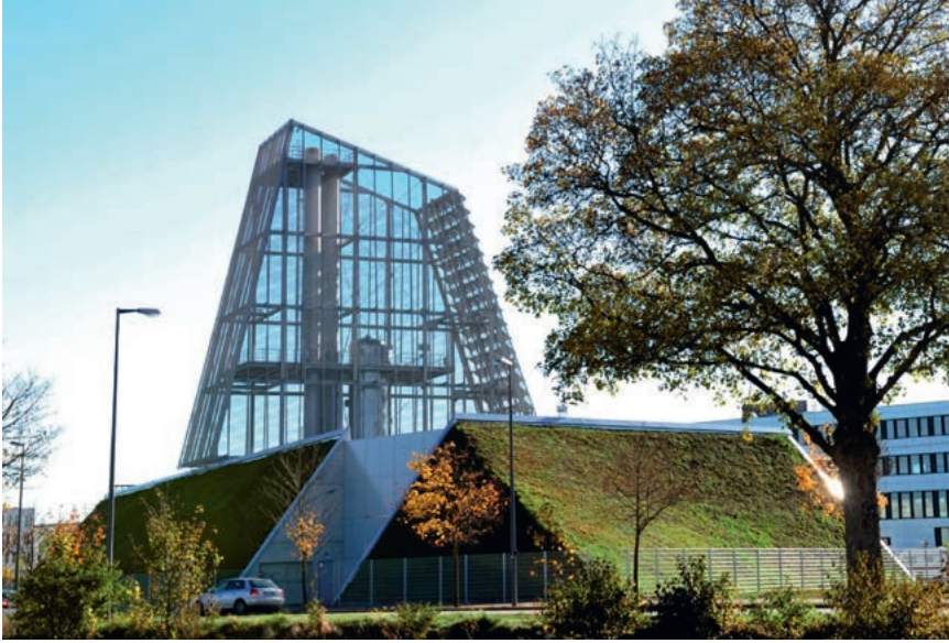
Blick auf das Geothermieheizwerk in Freiham.
