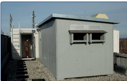
Taubenhaus auf einem Flachdach
