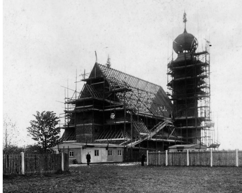
Auf einem freien Feld wurde die St. Canisius-Kirche direkt gegenüber dem neuen Schulhaus errichtet. Die Aufnahme zeigt den Rohbau im Jahr 1926.
