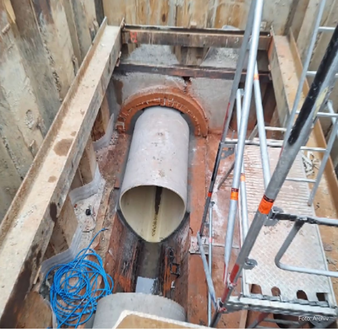
Kanalbau in offener Bauweise
