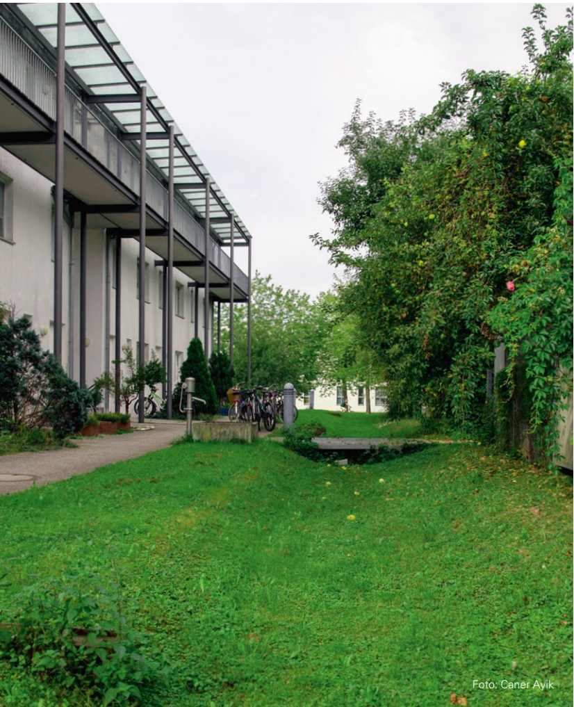
Versickerung in eine Mulde im Vorgartenbereich
