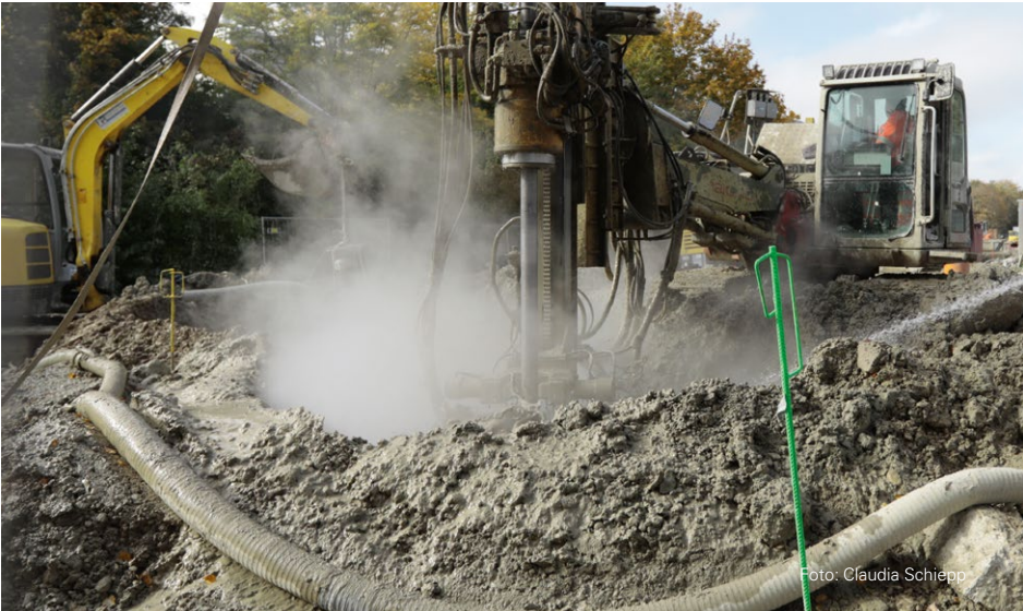
Baustellenbetrieb auf dem Klärwerk
