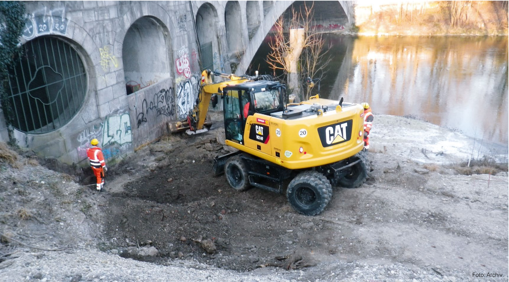
Kiesabtrag vor der Brücke am Montgelasdüker
