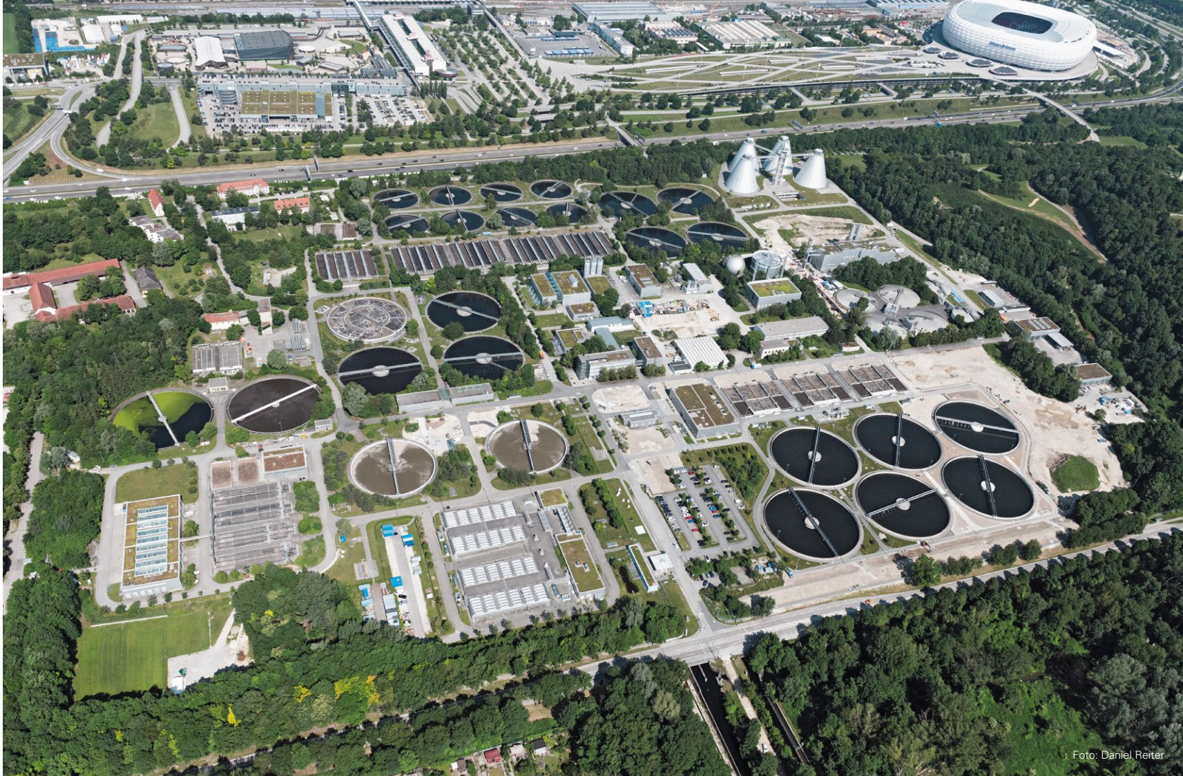
Zuverlässige Abwasserreinigung 24 Stunden an 365 Tagen im Jahr
