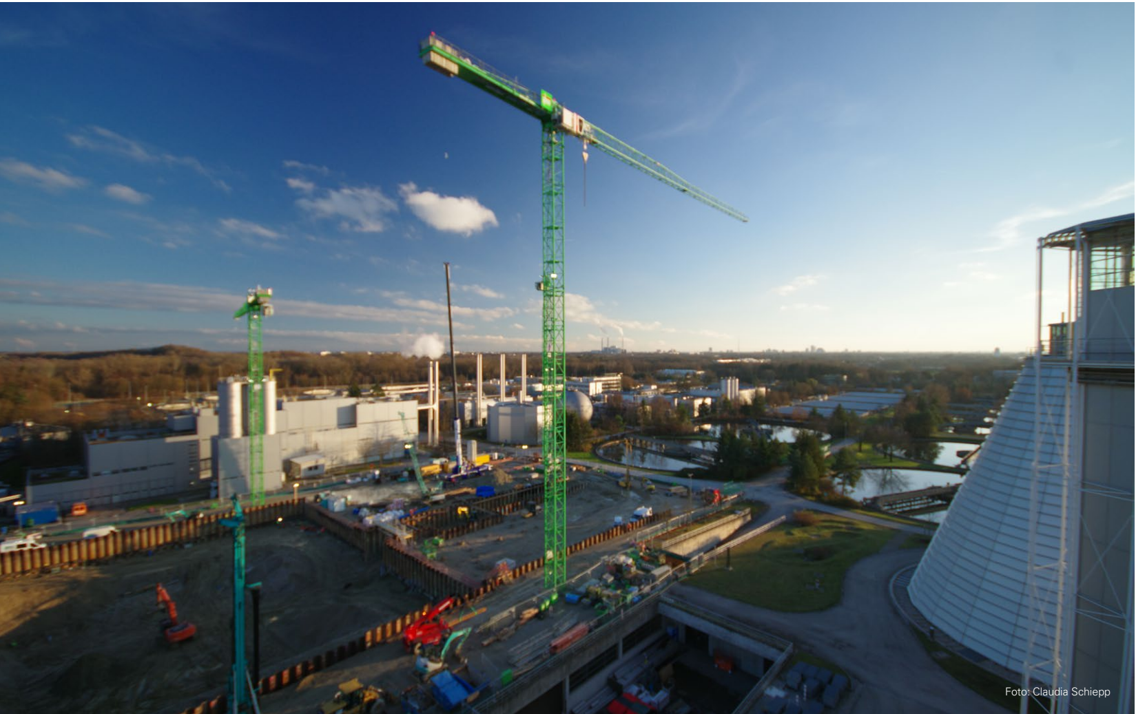
Sicht auf die Baustelle auf dem Klärwerk Gut Großlappen von einem Faulturm aus.
