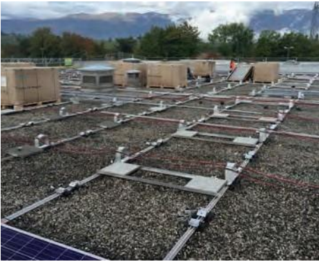
Abb. 9: Ballastierung des PV-Montagesystems mit Steinplatten (Foto: K2 Systems GmbH)
