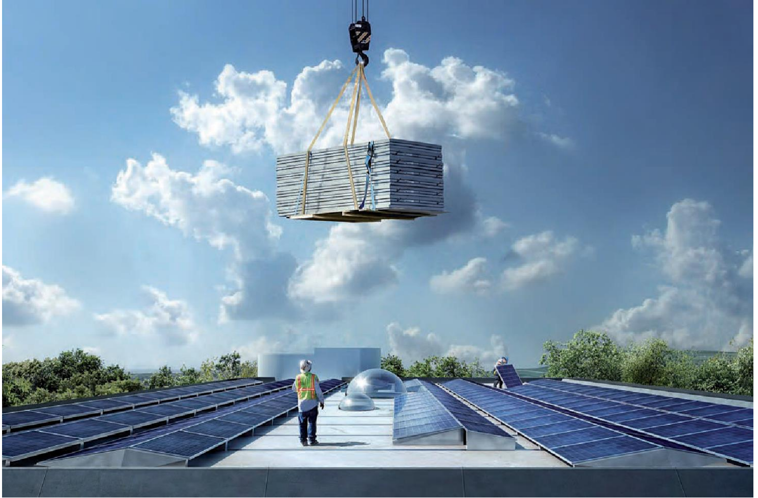
Abb. 1: Montage von PV-Modulen auf einem Flachdach – Powerhouse Kjørbo (Foto: Snøhetta und MIR; Quelle: SeV Bayern)
