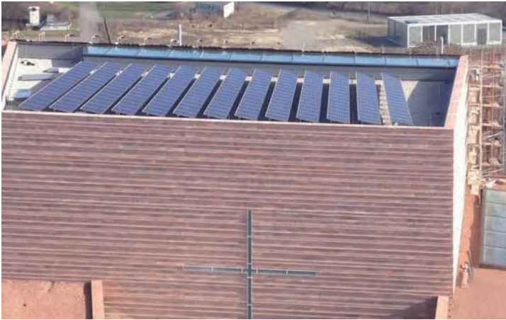
Abb. 6: Von der Straße nicht einsehbar – Flachdach der Katholischen Propsteikirche St. Trinitatis in Leipzig mit PV-Modulen in Südausrichtung (Schulz und Schulz, Leipzig; Foto: MLT Ingenieure; Quelle: SeV Bayern)
