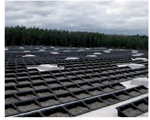
Abb. 11: Befestigungslösung mit kiesgefüllten Wannen als Ballastierung, die freistehend zu positionieren sind (Foto: Renusol Europe GmbH).
