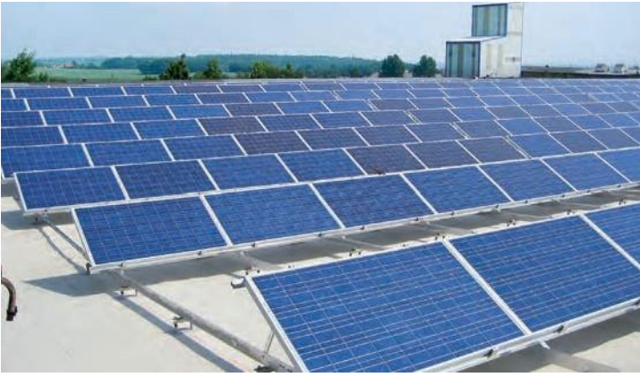
Abb. 2: Befestigung des PV-Montagesystems mit Betonankern direkt am Dach (Foto: ALTEC Metalltechnik GmbH)
