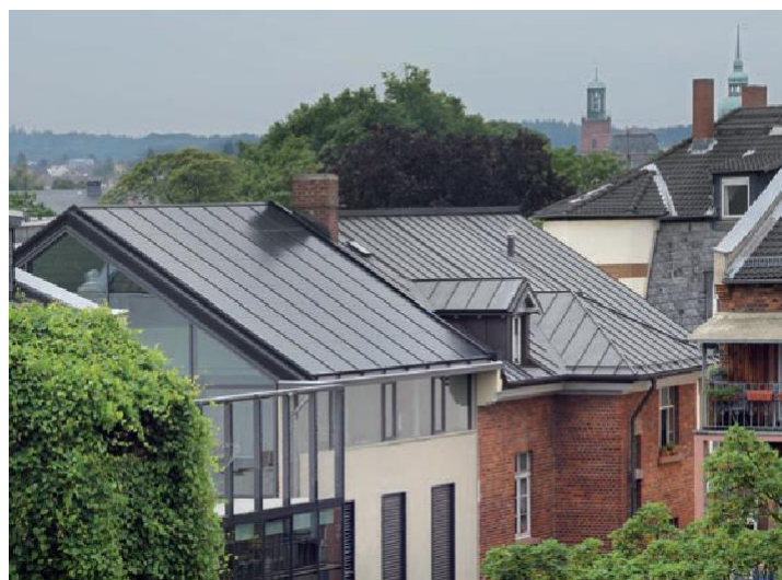
Abb. 2: Vollflächige Integration einer PV-Anlage in historischem Gebäudeensemble – opusHouse in Darmstadt (opus architekten BDA; Quelle: SeV Bayern).
