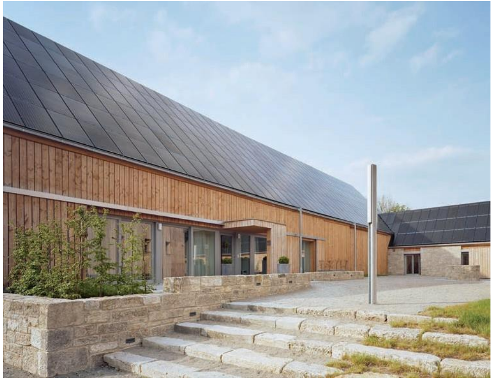
Abb. 8: Die PV-Anlage ist vollflächig in die Dachflächen integriert; Aufdachmontage mit sorgfältig detaillierter Behandlung der Dachränder – Hof 8 in Weikersheim (Architekturbüro Klärle; Foto: Brigida González; Quelle: SeV Bayern).
