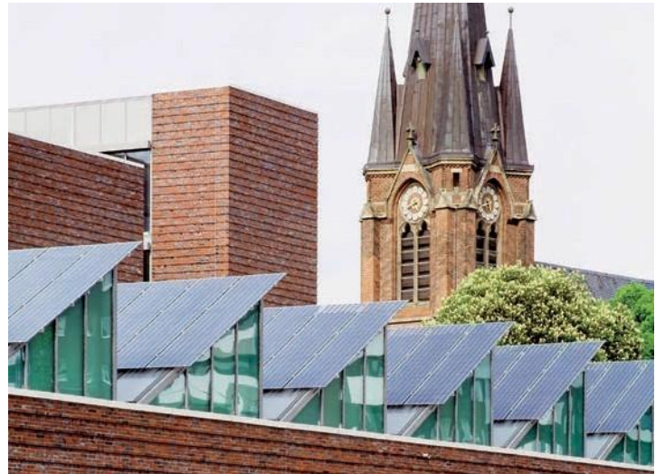
Abb. 5: „Ausragen“ der PV-Anlage über die Dachränder – Museum für Archäologie in Herne (von Busse, Klapp, Brüning Architekten; Quelle: Architekten Brüning Rein).
