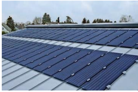
Abb. 13: Dachparallele Montage der PV-Module auf Metalldach in Stehfalztechnik – Einfamilienhaus in Willich (Foto: RHEINZINK).
