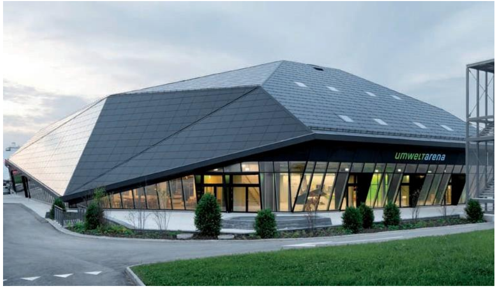
Abb. 4: Durch Verwendung von Dummymodulen an Graten und Kehlen entsteht eine optisch gleichmäßige Flächenausbildung – Umweltarena in Spreitenbach (René Schmid Architekten; Quelle: SeV Bayern).
