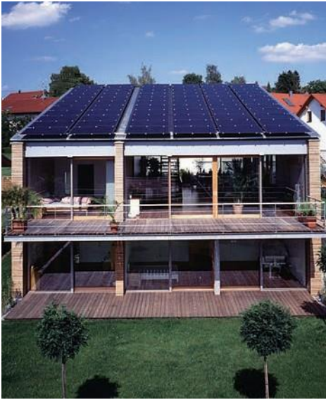
Abb. 3: Dimensionierung und Anordnung der PV-Anlage nehmen Bezug auf die Tragstruktur des Gebäudes – Einfamilienhaus in Hegenlohe (Architektur: Tina Wolf, Michael Resch; Quelle: SeV Bayern).
