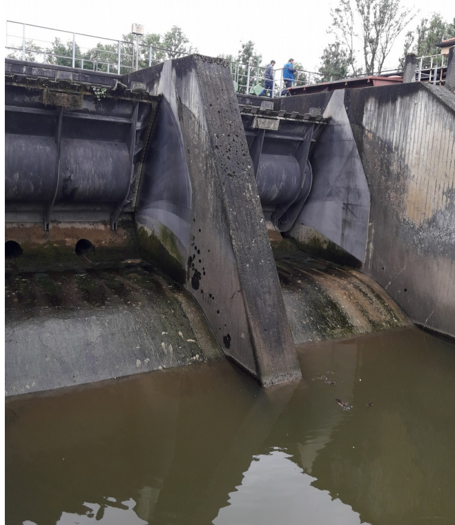
Abbildung 9: Überwasserentlastungsanlage des Isarwerk 1.
