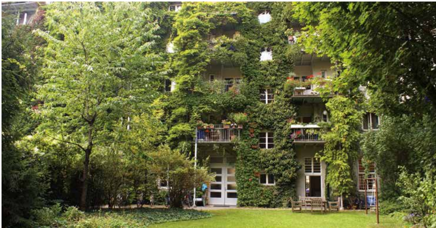
Diese Fassadenbegrünung aus mehreren Kletterpflanzen und die abwechslungsreiche Hofbegrünung wurde im Wettbewerb „Mehr Grün für München 2004“ mit einem Preis ausgezeichnet.
