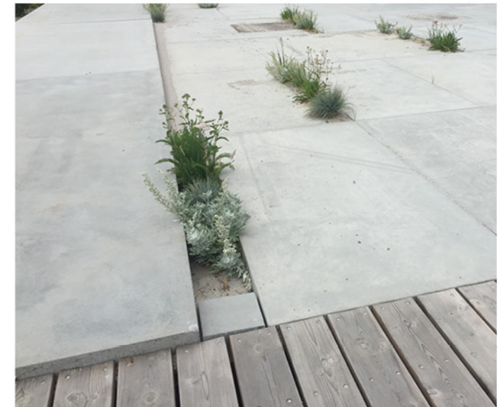
Abb. 31: Beispiel für hellen Bodenbelag mit unterschiedlichen Versickerungsgraden
