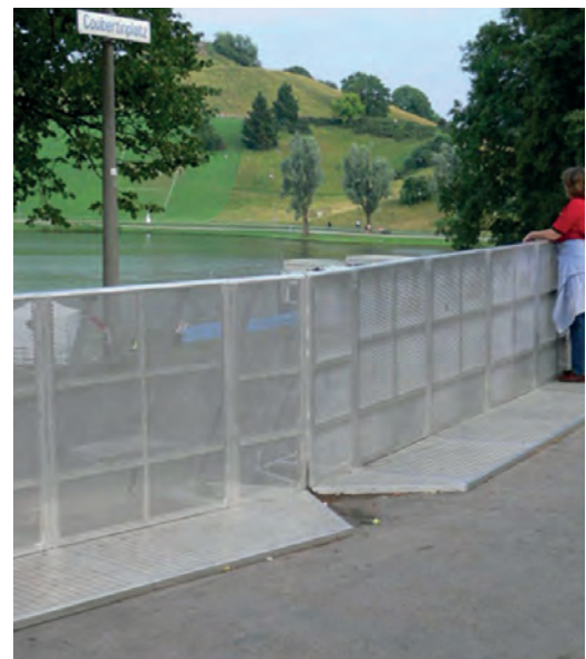
Abb. 13: Absperrung vor einem abfallenden Hang – Vorderansicht
