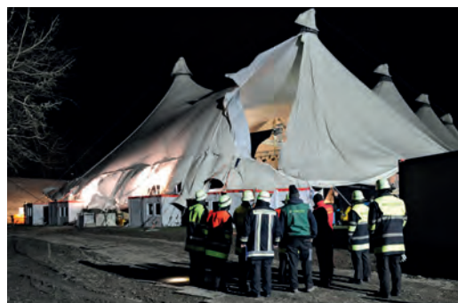
Abb. 46: Ein Veranstaltungszelt ist durch einen Sturm beschädigt worden und droht einzustürzen.
