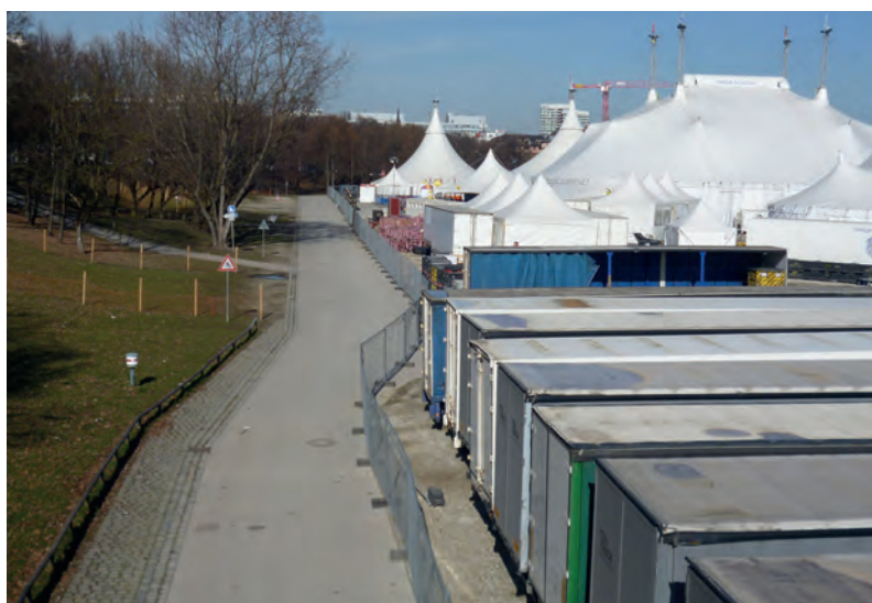
Abb. 5a: Bauzaunfelder zur Zutrittsverhinderung
