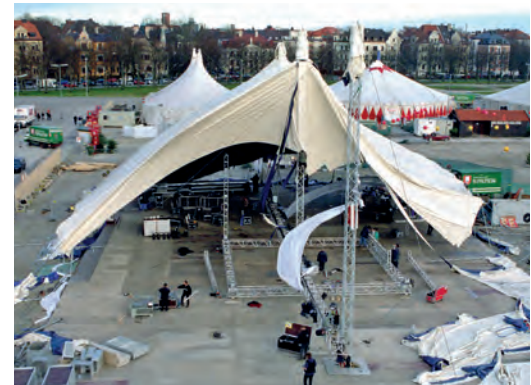
Abb. 13: Zelteinsturz nach Sturmböen
