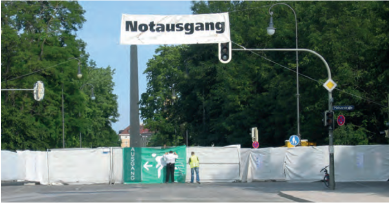
Abb. 6: Bauzaun als Sichtschutz mit Notausgangskennzeichnung; zu beachten sind mögliche Windlasten, die auf die Banner einwirken können.
