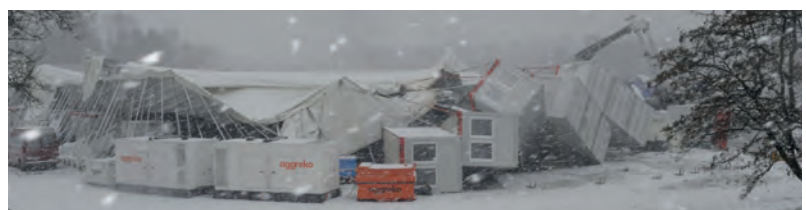
Abb. 47: Das Veranstaltungszelt am nächsten Tag. Trotz Maßnahmen der Feuerwehr in der Nacht, konnte ein Einsturz nicht verhindert werden. Die Kraft des Windes war so groß, dass sogar Baucontainer umgeworfen worden sind.
