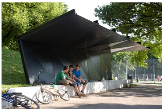
Wetterdach am Multifunktionsplatz (oben) Barrierefreie Toilettenanlage (unten)
