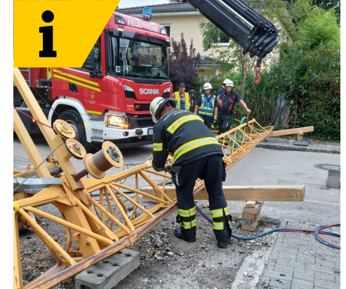
SEPTEMBER Baukran umgestürzt
