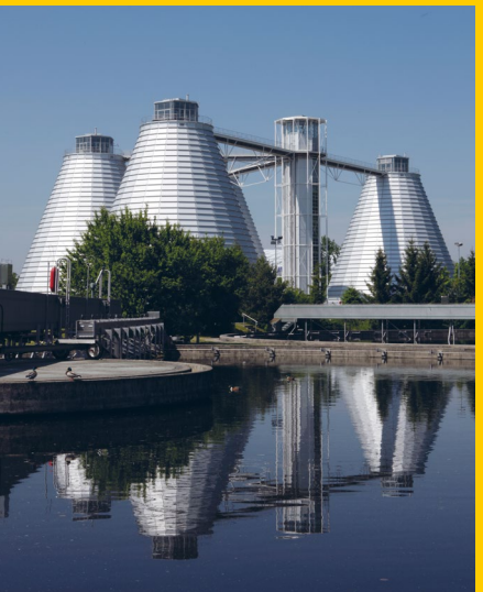
Klärwerk Gut Großlappen, Klärbecken und Faultürme
