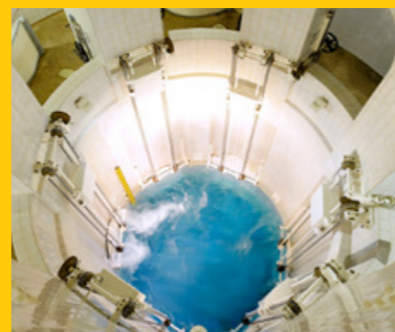
Reisacher Grundwasserversorgung (SWM)
