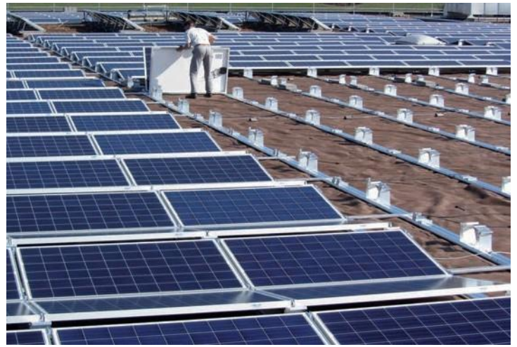
Abb. 3: Montage von ost/west-orientierten PV-Modulen auf die Unterkonstruktion (Foto: IBC Solar).
