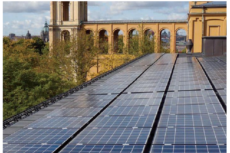
Abb. 4: Dachparallel montierte PV-Anlage (8° Neigung) – Bayerischer Landtag in München (Foto: Green City).
