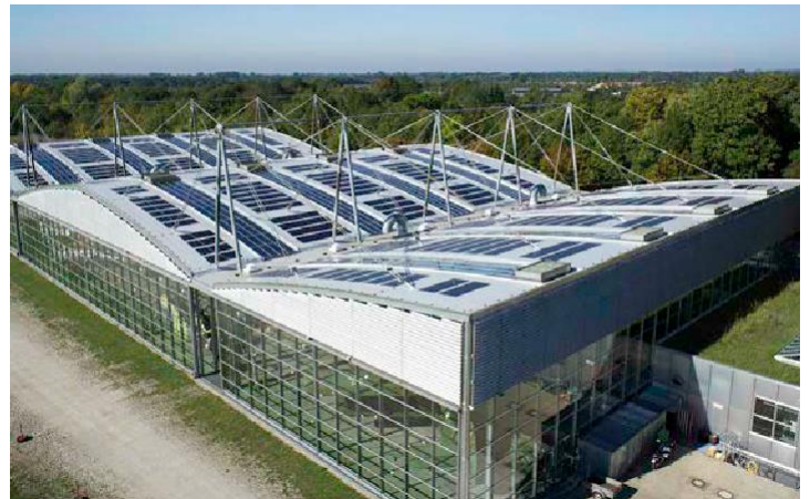
Abb. 8: Dachhaut mit auflaminierten PV-Modulen – Flugwerft Oberschleißheim (prpm Architekten + Stadtplaner, Foto: alwitra Flachdachsysteme).
