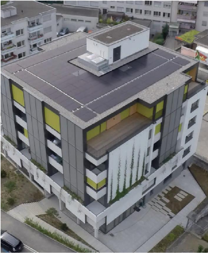
Abb. 5: Dachparallel montierte PV-Anlage mit klarer Flächenzonierung – Mehrfamilienhaussanierung in Zürich mit Solarthermie-Fassade (Kämpfen für Architektur; Quelle: SeV Bayern).
