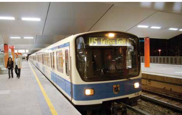
Der modernisierte U-Bahnhof Neuperlach Süd
