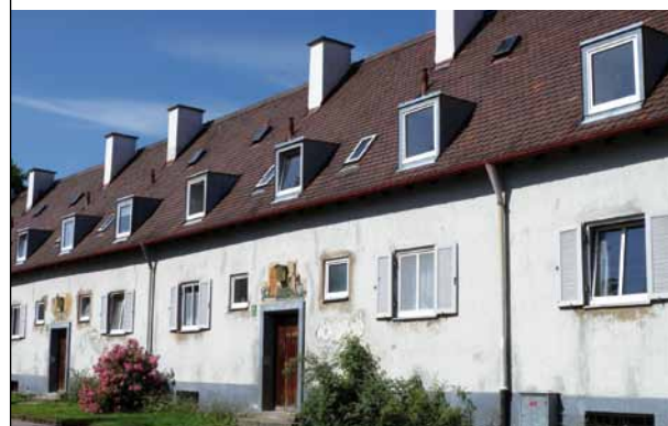
Vorbereitende Untersuchungen zur Erstellung eines Stadtentwicklungskonzepts laufen in Neuaubing/Westkreuz.
