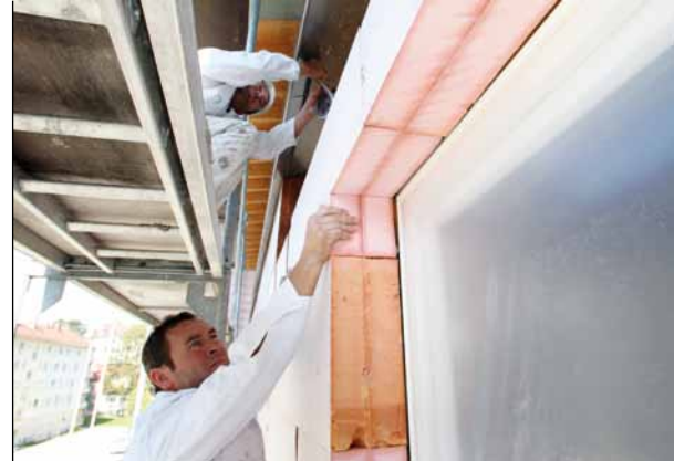
Im Rahmen des Konjunkturpaketes II wurden zahlreiche städtische Gebäude energetisch saniert.
