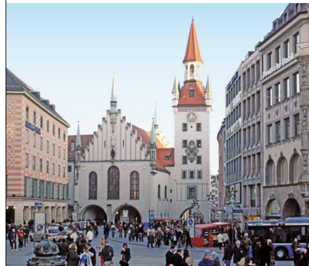
Die Sanierungsarbeiten am Alten Rathaus wurden im November 2011 abgeschlossen.
