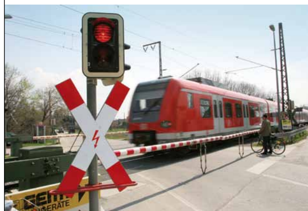
Beim Ausbau der S 8 im Bereich Daglfing – Johanneskirchen hat sich der Stadtrat für die Tunnelvariante ausgesprochen.
