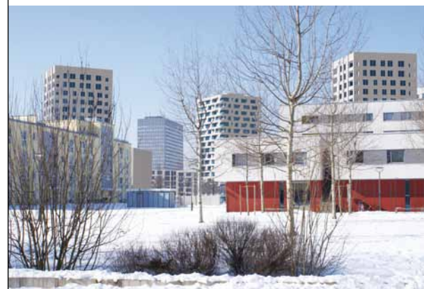
Auf dem Gelände um den S-Bahnhalt Siemenswerke entsteht ein neues Quartier mit insgesamt 950 Wohneinheiten.
