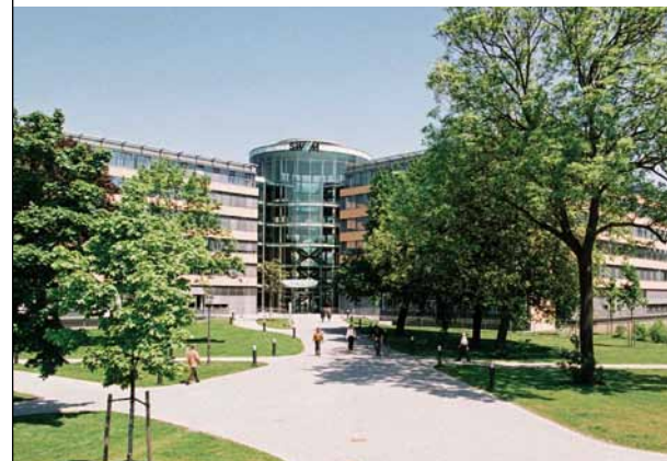
SWM-Zentrale an der Emmy-Noether-Straße
