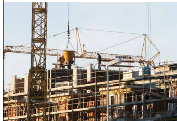
Die Stadt sorgt für die Sicherung von Mindestlohnpflichten bei Ausschreibungen von Bauleistungen.
