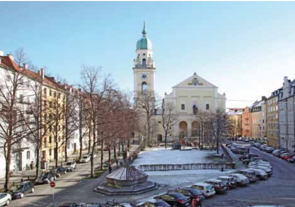
Am Josephsplatz wird eine Anwohner Tiefgarage gebaut.
