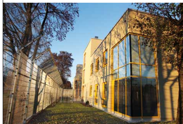
Jugendhilfezentrum in der Scapinellstraße
