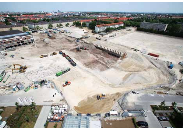
Im Planungsgebiet „Agfa“ entstehen rund 950 Wohneinheiten.
