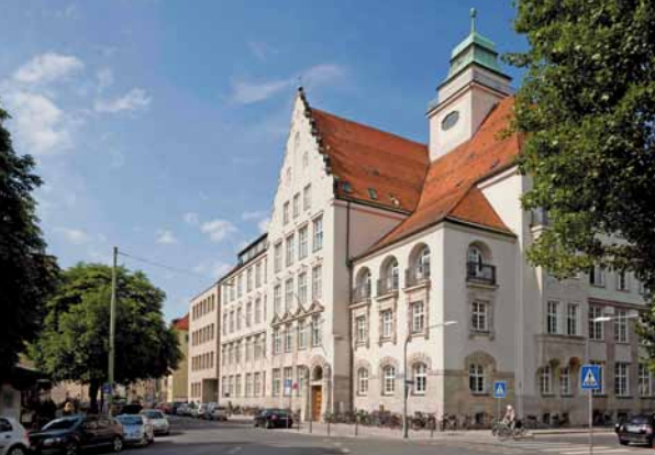
Das Gisela-Gymnasium wurde instand gesetzt und erweitert.
