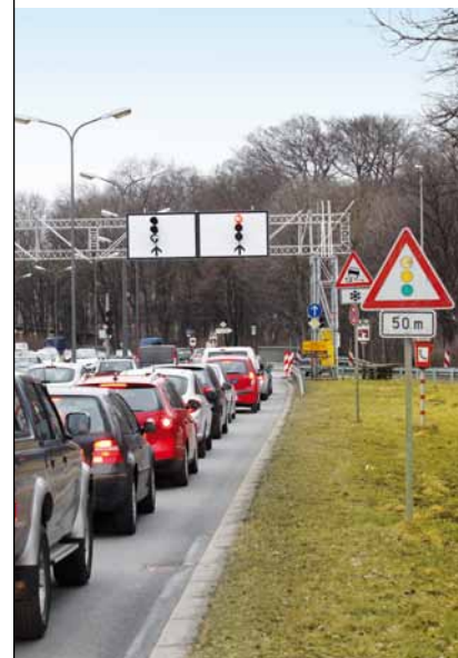
Am Isarring wurde eine „Fahrspursignalisierung“ realisiert.
