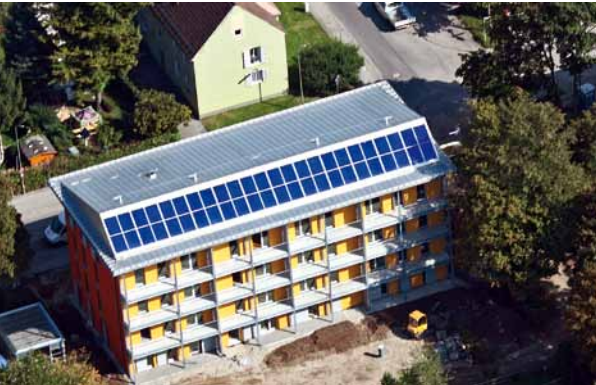
Passivhaus der GWG mit 13 Wohnungen in Harthof
