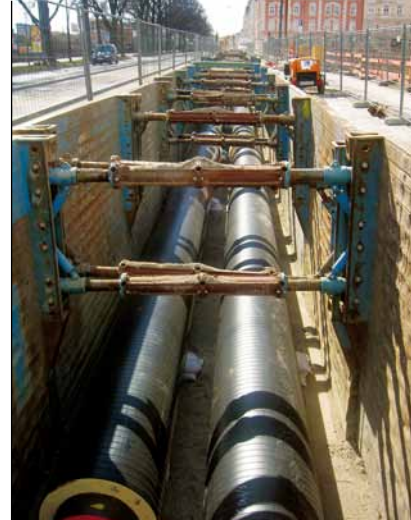
Die SWM bauen die Fernwärmeversorgung weiter aus.
