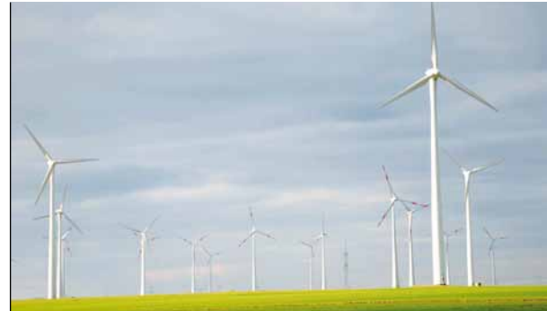
In Kooperation mit dem Windkraftspezialisten wpd werden die SWM weitere Onshore-Windparks in Europa in Betrieb nehmen.
