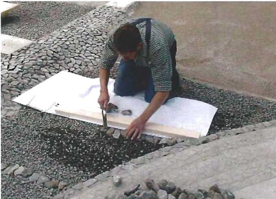
Abb. 15: Stein für Stein wird die neue Rampenstruktur gesetzt
