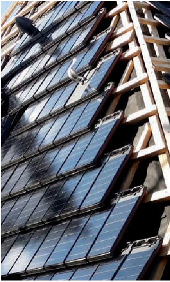
Abb. 9 Solardachziegel (links, Foto: Autarq) und PV-Dachschindeln (rechts, Foto: SolteQ, Quelle: SeV Bayern) ermöglichen eine kleinteilige Flächenbelegung.
