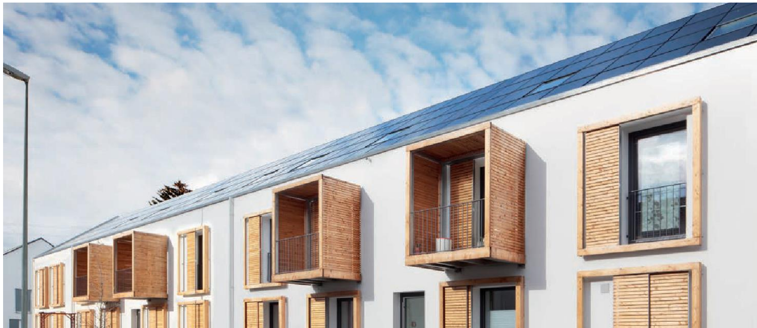
Abb. 1: Indachmontage einer vollflächigen PV-Anlage mit integrierten Dachfenstern – Effizienzhaus Plus im Altbau, Neu-Ulm (o5 Architekten BDA Raab Hafke Lang; Foto: Eibe Sönnecken; Quelle: SeV Bayern)
