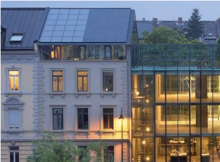
Abb. 4: Solarkollektoren (links) und Photovoltaik (rechts) in einem Indach-Montagesystem – opusHouse, Darmstadt (opus Architekten BDA; Foto: Eibe Sönnecken; Quelle: SeV Bayern).
