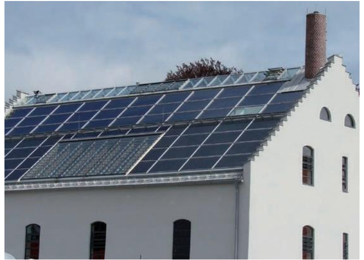
Abb. 5: Energiedach mit Dachfenstern und Oberlichtband im Gebäudebestand – ehemaliges Brauereigebäude in Bad Tölz (Lichtblau Architekten; Quelle: SeV Bayern).
