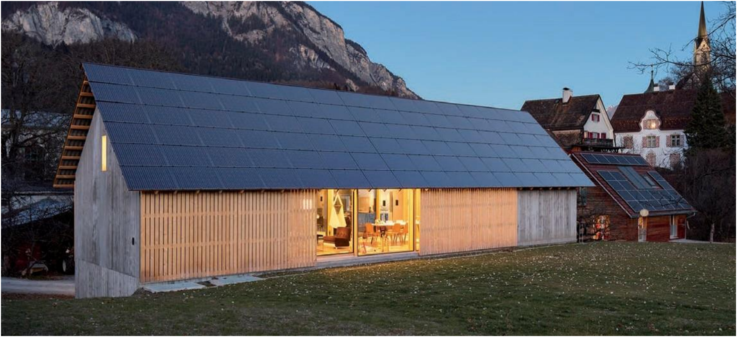
Abb. 7: Vollflächige, über die Dachränder hinausgeführte PV-Anlage mit Unterkonstruktion aus Holz – Einfamilienhaus in Tamins (Bearth & Deplazes Architekten, Foto: Ralph Feiner; Quelle: SeV Bayern).
