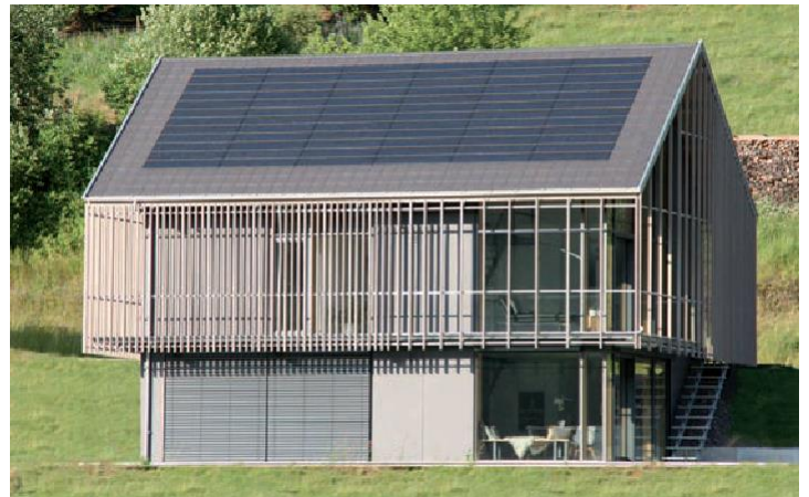
Abb. 8: PV-Indach-System für Betondachsteine; das querformatige Modul umfasst die Länge von sechs Dachpfannen – Einfamilienhaus in Schluchsee (Schaller + Sternagel Architekten, Foto: Wolfgang Scheide; Quelle: SeV Bayern).
