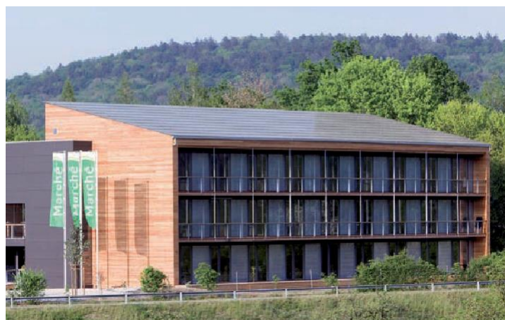
Abb. 2: Vollflächige PV-Anlage mit kleinformatigen Glasschindeln und äußerst sorgfältiger sowie eleganter Detaillierung der Dachränder – Bürogebäude in Kempththal (Kämpfen für Architektur; Foto: Willy Kracher; Quelle: SeV Bayern).
