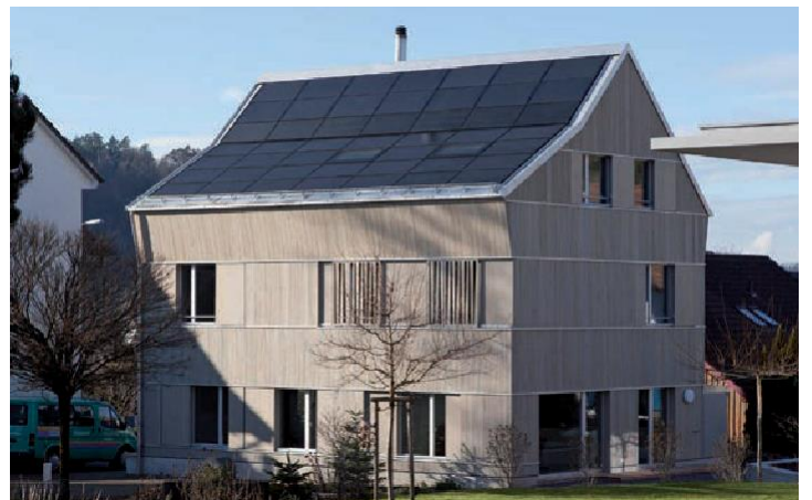
Abb. 6: PV-Module, Solarkollektoren und Dachfenster in Profilsystem integriert; unterschiedlich geneigte Dachflächen nehmen auch Bezug auf die Nutzungsart der Solartechnik – Einfamilienhaus in Glattfelden (Mirlo Urbano Architekten; Quelle: SeV Bayern).
