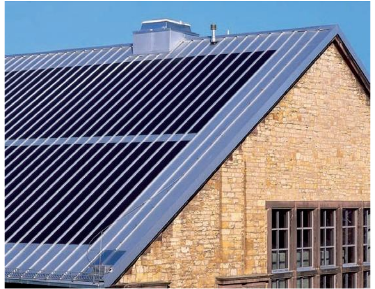
Abb. 10: Flexible PV-Laminat auf Metaldach – Sanierung Artilleriekaserne in Osnabrück (Planungsbüro Rohling; Foto: Thyssen Krupp).
