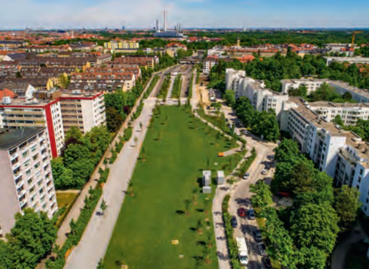
Mit dem Heckenstallerpark sind 27.500 Quadratmeter Parklandschaft über dem Tunnel entstanden.
