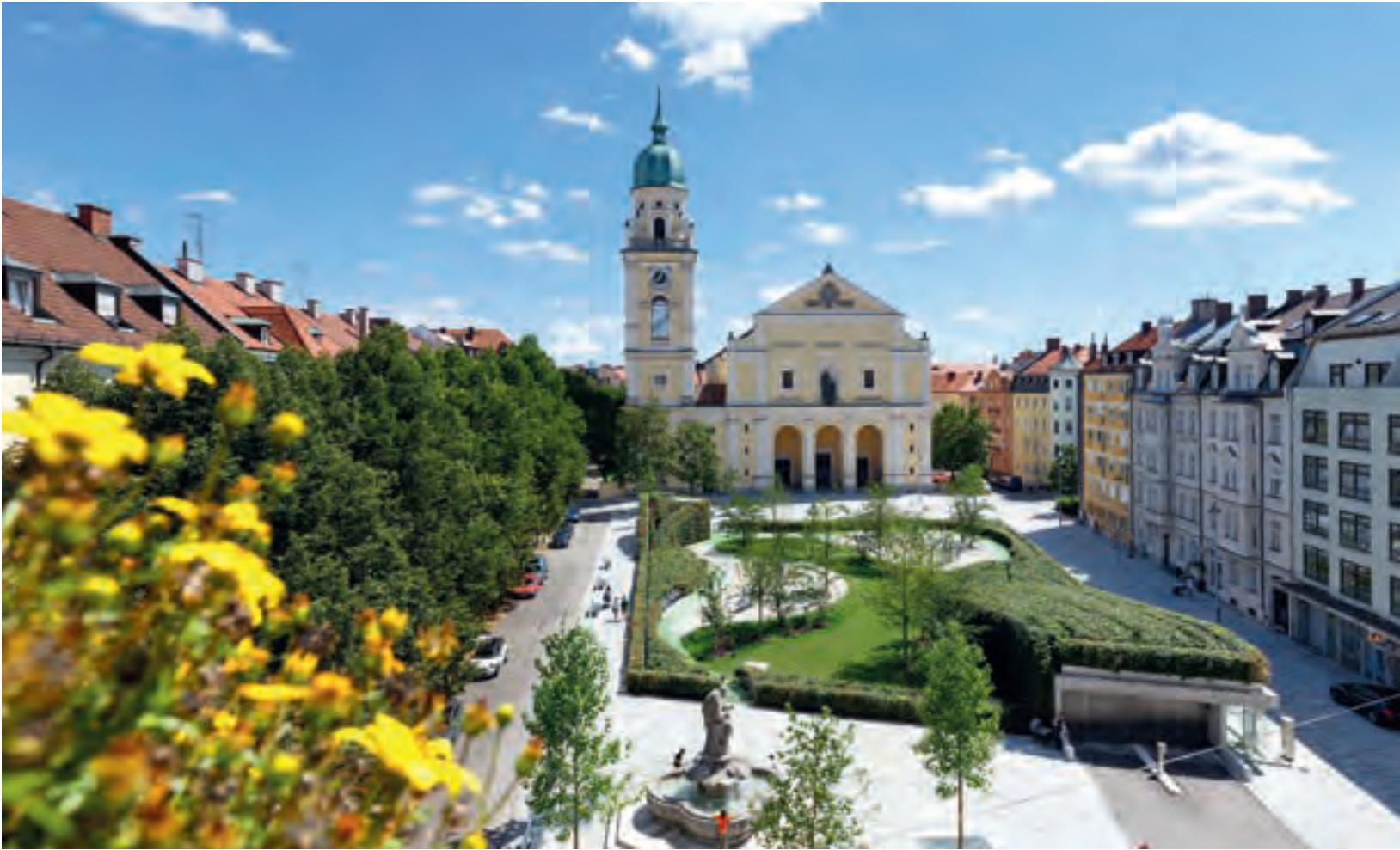
Durch den Bau der Tiefgarage konnten die Fahrbahnlflächen reduziert und mehr Freiraum geschaffen werden.
