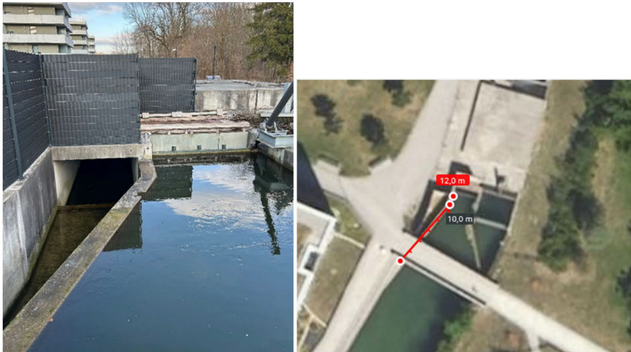
Abbildung 2: Streichwehr am Kraftwerk Freimann (Foto, links: Ingérop, 15.01.2025, Orthobild, rechts: BayernAtlas)
