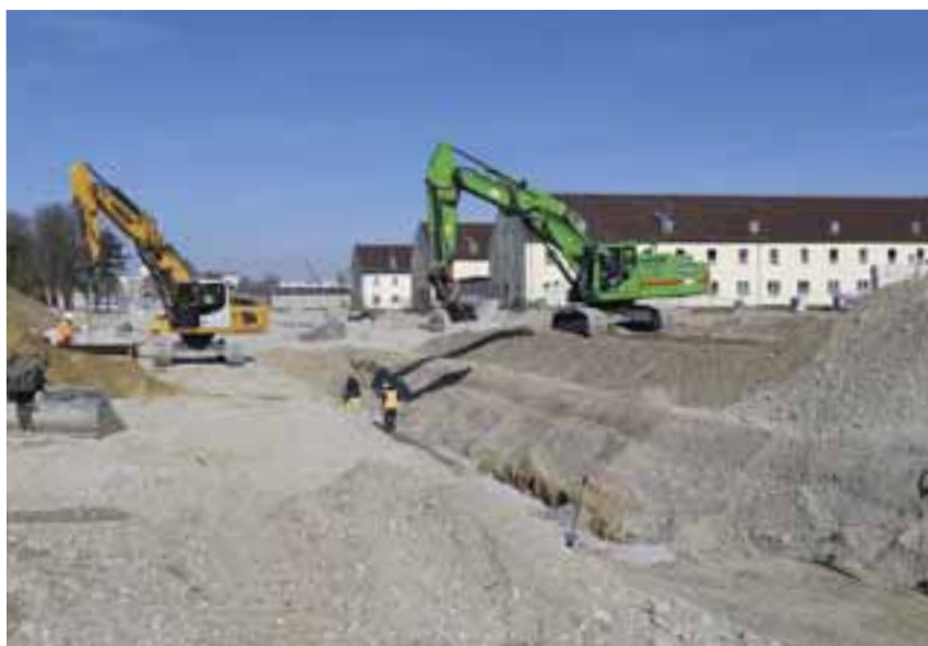
Kanalbau im Erschließungsgebiet Neufreimann (ehem. Bayernkaserne)
