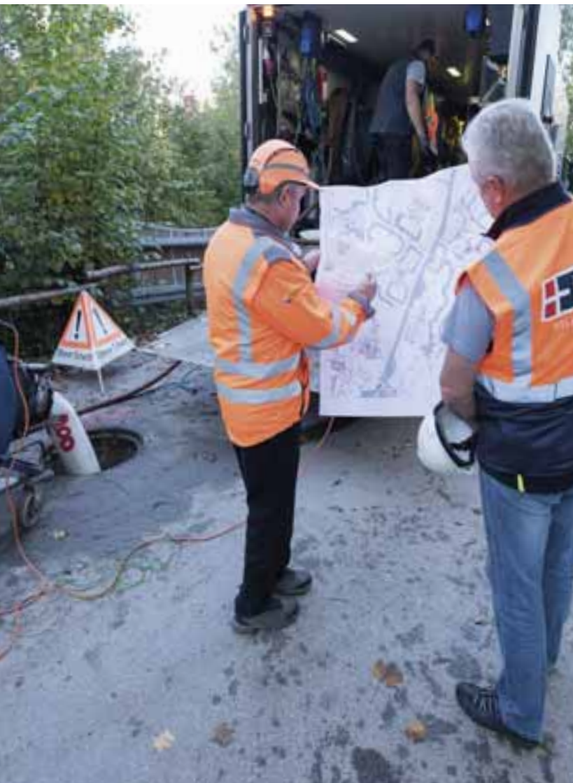
Besprechung eines Mitarbeiters der Grundstücksentwässerung mit einem Mitarbeiter einer Sanierungsfirma
