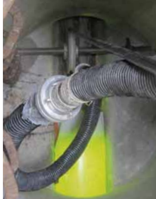
Rohrkanalsanierung: Schlauchrelining mit UV-Aushärtung
