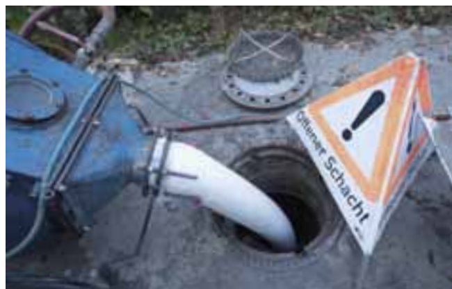
Sanierung einer Entwässerungsleitung im Tierpark Hellabrunn
