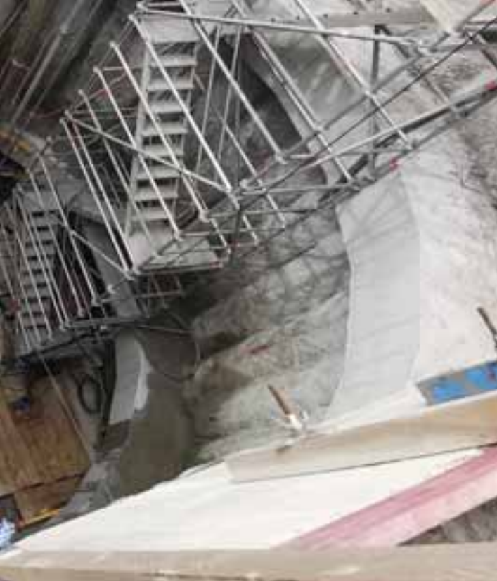
Neubau Düker Montgelasstraße - Einfahren der Vortriebsmaschine in Bohrfahrlwand
