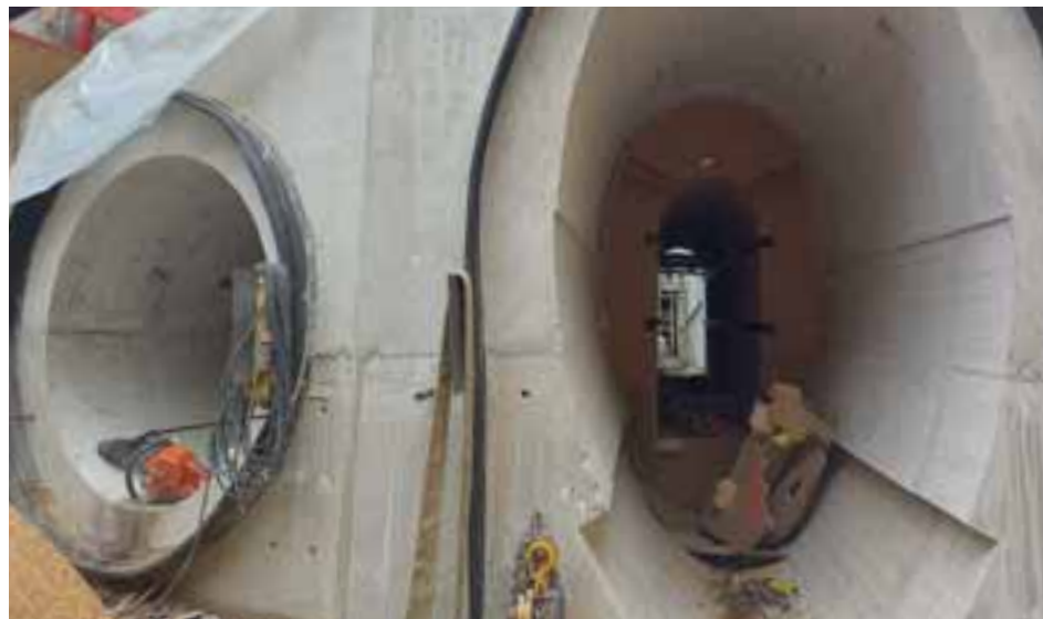
Neubau Düker Montgelasstraße – Doppelkanal
