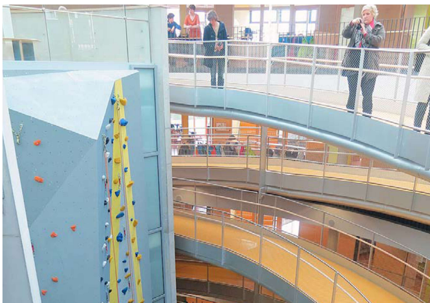
Das Atrium in der Barlachschule in München ist barrierefrei als Rampenanlage gestaltet
