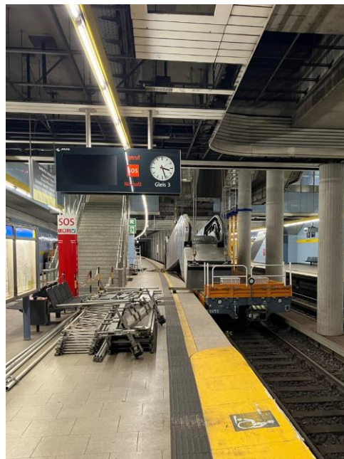
Ein Fahrtreppenteil am Max-Weber-Platz wird ausgehoben und abtransportiert.
