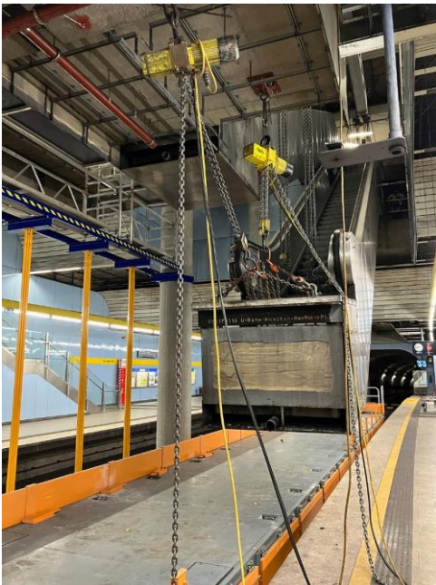
Ein Fahrtreppenteil am Max-Weber-Platz wird ausgehoben und abtransportiert.
