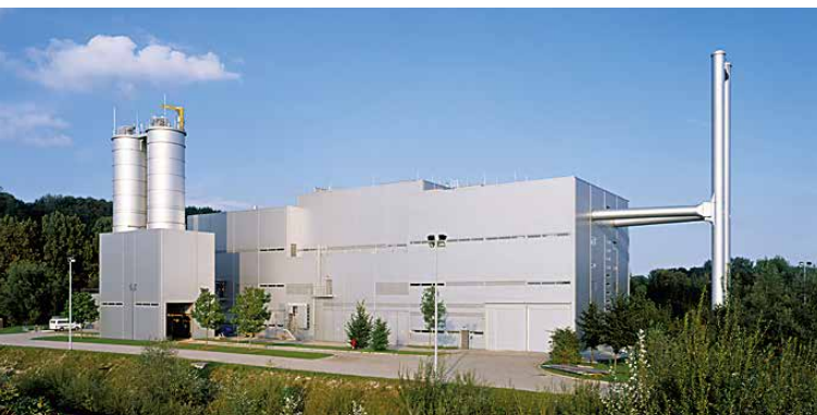
Klärschlammverbrennungsanlage (KVA) des Klärwerks Gut Großlappen
