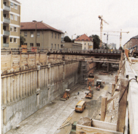
U-Bahnbaustelle in der Gotthardstraße in den 1980er Jahren; hinten die Villa Groh.
