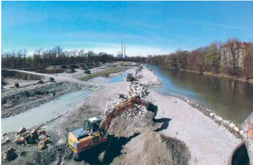
Abb. 85 Arbeiten zur Renaturierung der Isar (Isarplan)
