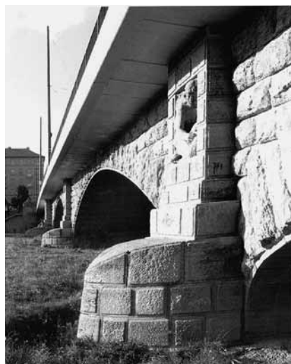
Abb. 27 Bauliche Anpassung der Reichenbachbrücke an verkehrstechnische Erfordernisse
