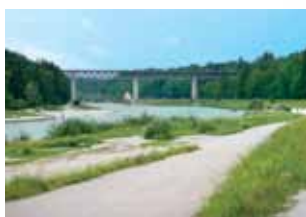
Abb. 17 Isar/ Großhesseloher Brücke
