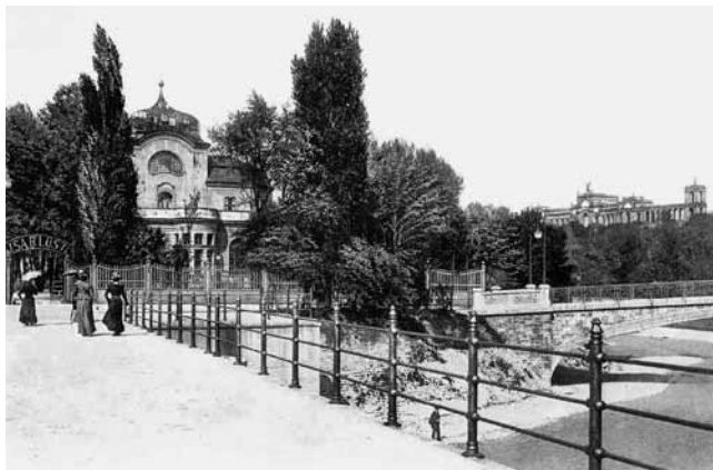
Abb. 26 Ehemaliges Geländer am Wehrsteg (Wehr IV)
