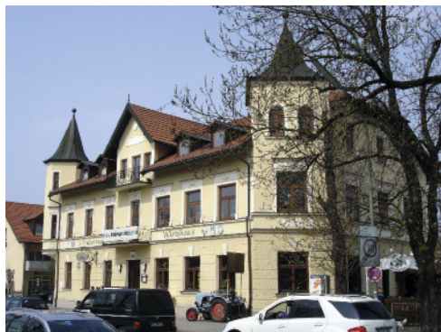
1998 bezog »s Truderinger Wirtshaus« den historischen Wirtshausbau mit den markanten Ecktürmen.
