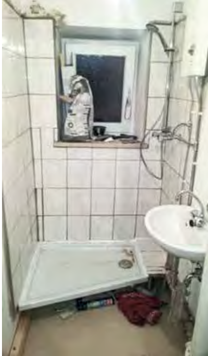
Badausbau im Jahr 2017 in einer Wohnung in der Karlingerstraße.
