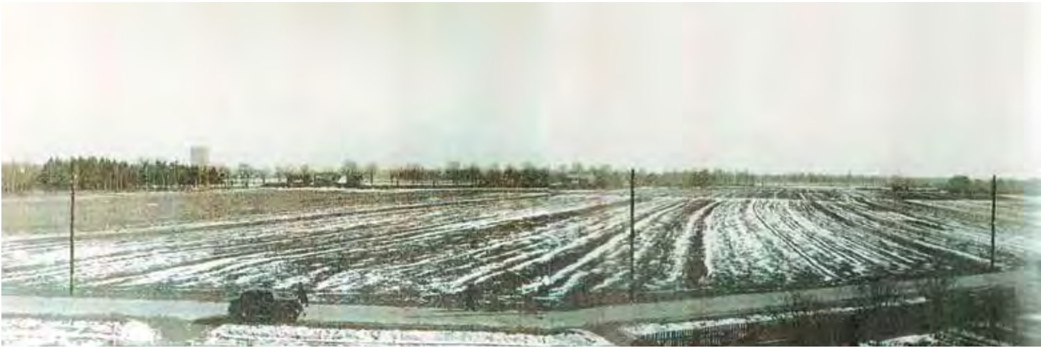
Das Baugelände der Siedlung zwischen damaliger Maria-Ward- und Pasinger Straße (im Vordergrund). Im Hintergrund ist der ehemalige Gaskessel des Gaswerks Moosach zu sehen. Aufnahme vom 28. Februar 1941 vom Standort in Höhe Kapellenackerstraße, Blick nach Osten.
