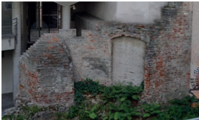
Abb. 26: Reste des ehemaligen Scheiblings
